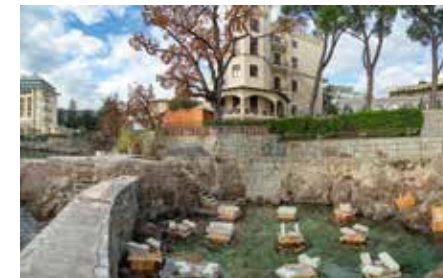
Kleine Bucht: Betonstützen für die Plattform.
