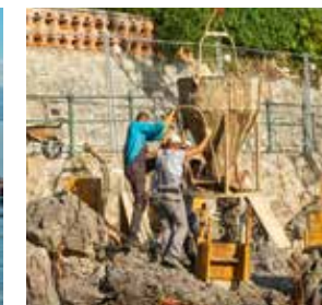
Kleine Bucht: Betonstützen für die Plattform.
