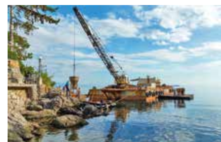
Ein Großteil der benötigten Baustoffe wurde auf dem Seeweg angeliefert, etwa die Steine für das Fundament. Den ersten Wintersturm (Jugo) haben die Betonfundamente bereits gut überstanden.
