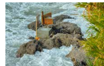
Ein Großteil der benötigten Baustoffe wurde auf dem Seeweg angeliefert, etwa die Steine für das Fundament. Den ersten Wintersturm (Jugo) haben die Betonfundamente bereits gut überstanden.
