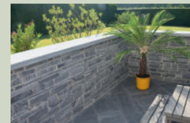
Mauersteine gespalten und Abdeckplatten gestockt/gebürstet.
