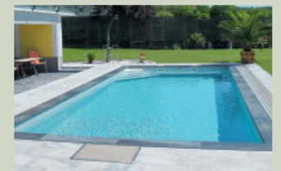
Gestockte, rutschsichere Poolabdeckplatten und Bodenplatten gestockt/gebürstet.
